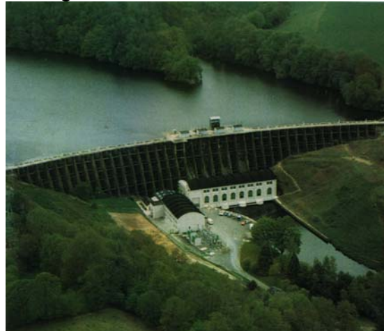
Barrage de Vezins
